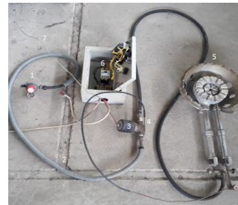
Gambar 3. Hasil Perakitan Regulator yang terhubung dengan Piranti kontrol dan Burner
